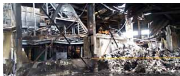
再生処理事業者の発火事故現場（写真提供：日本容器包装リサイクル協会）
